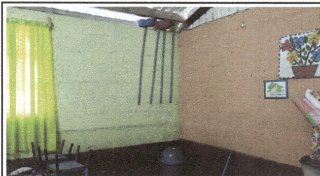
Foto 6: Aula 2 del módulo 1 con paredes que se desmoronan al no tener un recubrimiento, se necesita repello y pintura.
